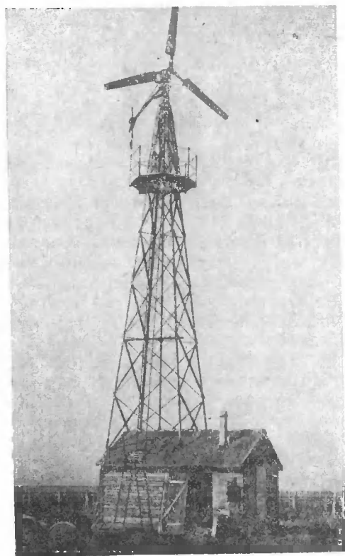
Фиг. 12. Ветроэлектрическая станция ВИМЭ—Д-5 на 1 квт.
